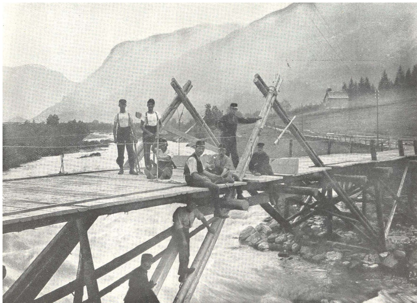
Abb. 6.4: Einsatz von Genietruppen während der Überschwemmungen von 1910: Wiederherstellung der Poststrasse in Muotathal und der Strassenbrücke über die Muota bei Rambach. Quelle: Genie-Abteilung 1910: Bild 1 und 2.
