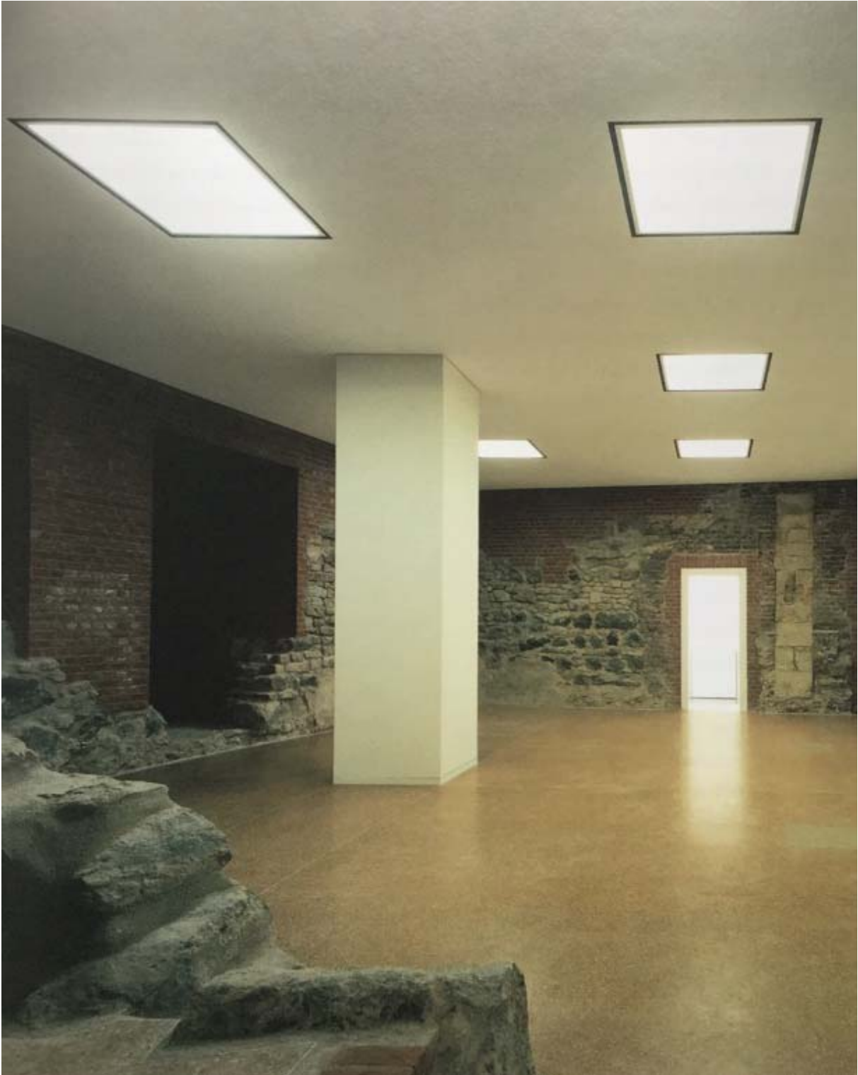
Abb. 9: Untergeschoss mit historischer Bausubstanz – 2001 Wallraf-Richartz-Museum (Ungers-Bau), Köln
