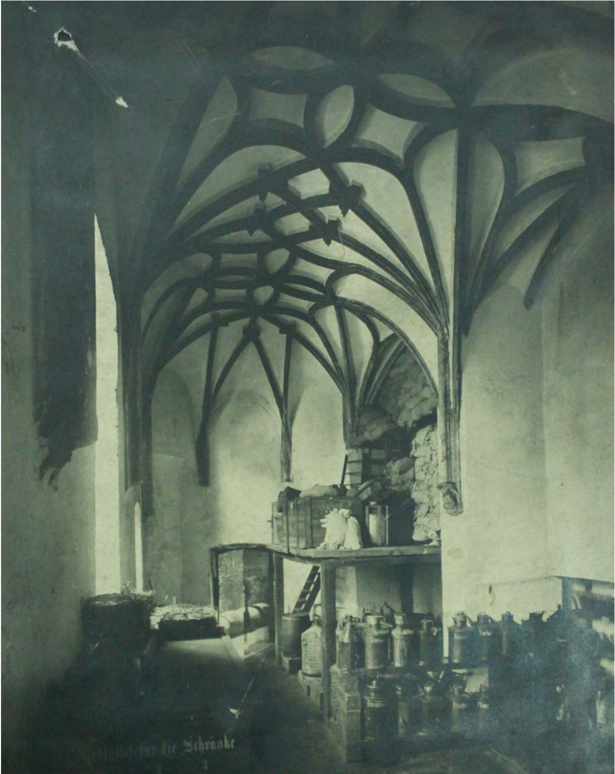
Abb. 102: Sakristei der ehemaligen Kartäuserkirche St. Barbara Zwischennutzung als Lagerraum – vermutlich um 1919 Archivalie des EGAK – ohne Inventarnummer
