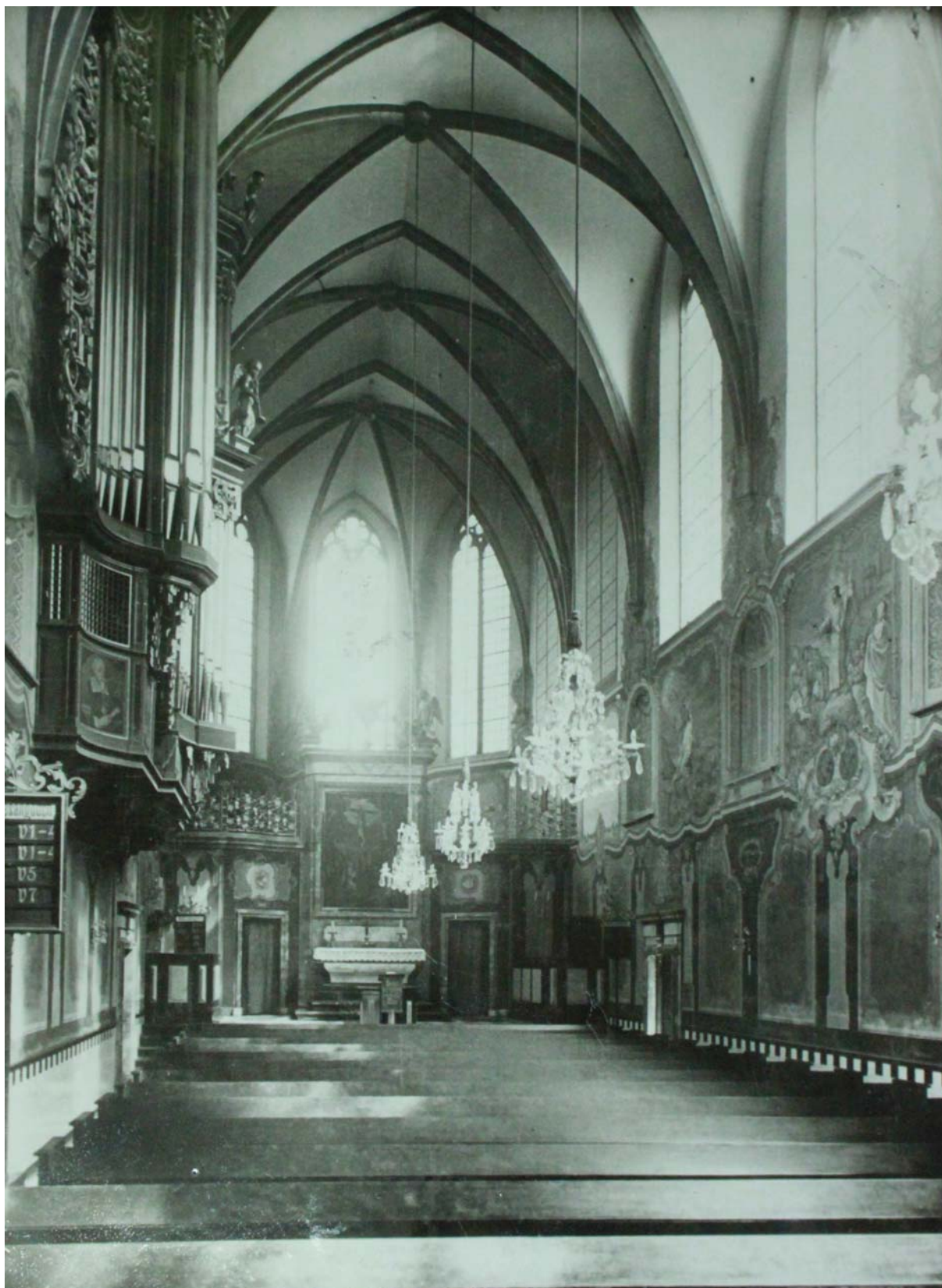
Abb. 84: Zustand der Kirche St. Barbara zum Zeitpunkt der Einweihung 1928 Interieur nach Fertigstellung der Instandsetzungsarbeiten – Blick nach Osten – 1928 Archivalie des EGAK – ohne Inventarnummer
