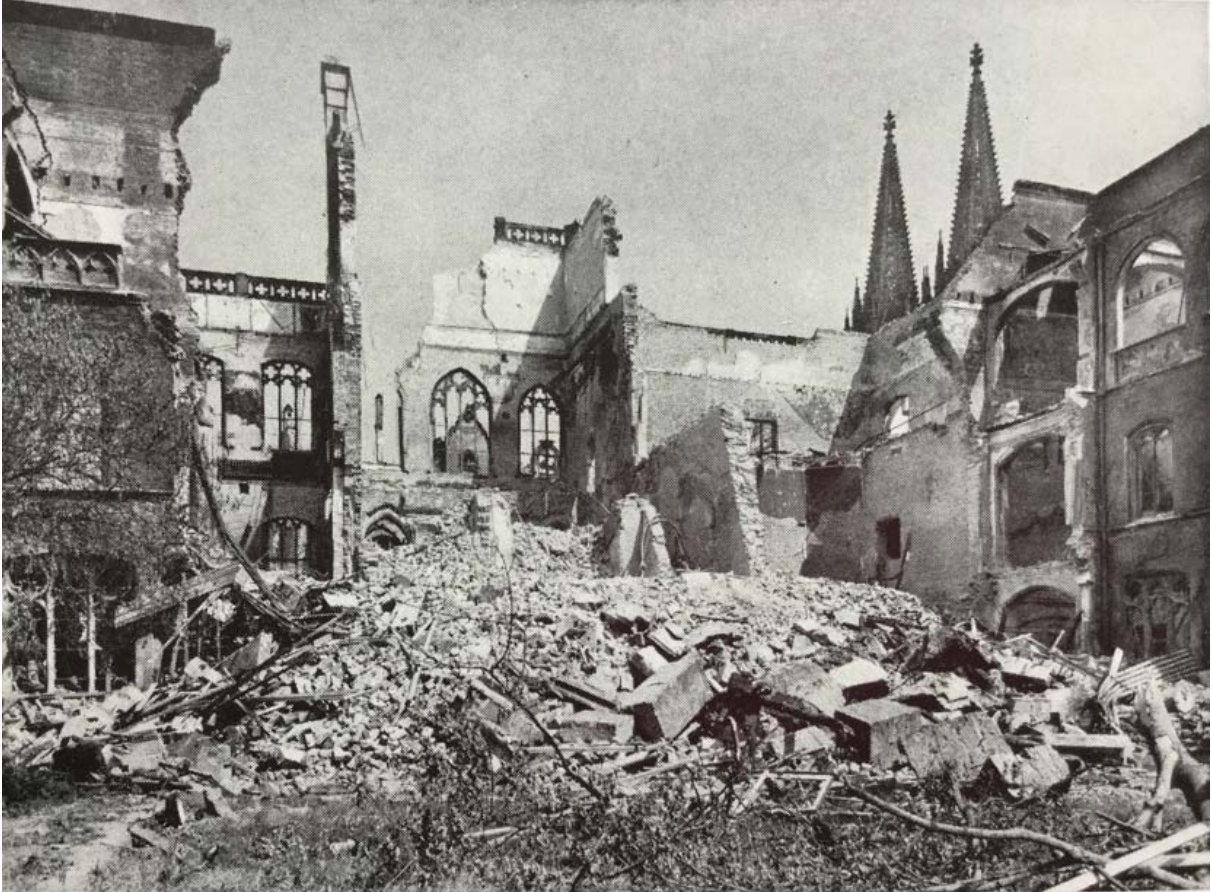
Abb. 183: Ansicht des kriegszerstörten Innenhofes des Wallraf-Richartz-Museums Photographie – undatiert (spätestens nach Mai 1945) Sammlungszugehörigkeit und weitere Informationen unbekannt
