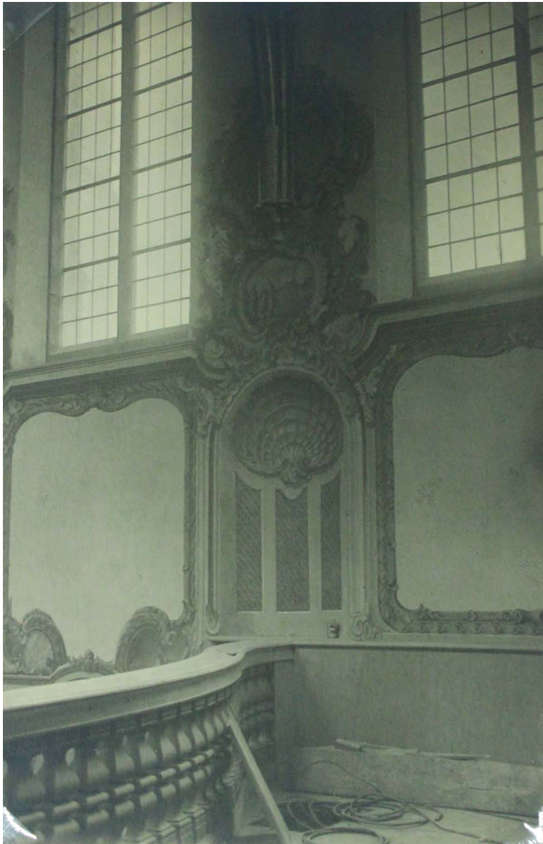
Abb. 87: Zustand der Kirche St. Barbara zum Zeitpunkt der Einweihung 1928 Interieur im Bauzustand – Empore mit Blick auf die Südwand – datiert um 1928 Archivalie des EGAK – ohne Inventarnummer
