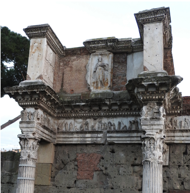
Abb. 22 Forum Transitorium, Rom. Südöstliche Umfassungsmauer.
