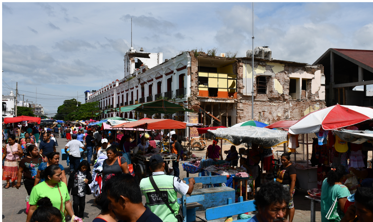
Gzzz, Palacio municipal de Juchitán dañado por el terremoto de 2017 (2), CC BY-SA 4.0
